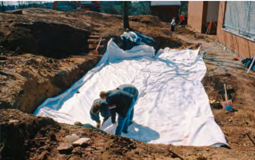
Schutzvlies. Bevor die scharfkantigen Betonplatten auf den sandweichen Untergrund dürfen (oohhhh!), dürfen Sie die Folie (ahhhhh!) nicht durchstoßen, also notgedrungen eine Lage Vlies darüber. Fertig ist der Unterbau. Und nun kommt die Kür. Dazu brauchen wir kurz mal den Bauleiter: „Steeeeeäähhfan!“
