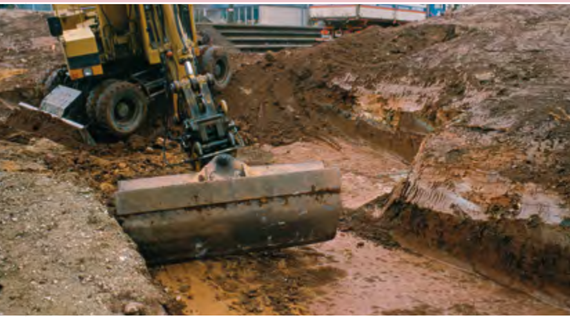
Teichgrube auskoffern. 3 Das Ende des Regenwasserbachlaufes in Dietenhofen (S. 116). Ein beiderseits eng begrenzter, nur 40 cm tiefer Naturteich. Hier endet alles Wasser. Übrigens: Immer mal hoch- und rumgucken: Im Hintergrund lagert potentielles Baumaterial. Betonplattentreppen. 7 Rechtzeitig sichern!
