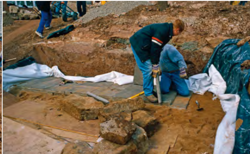
Sandschutzschicht 2 und Betonplatten. Auf eine erneute Ladung von 5 cm Sand kommen nun am Rand Gehwegplatten übereinander. Basis einer den Teich umrandenden und die Teichufer staibilisierenden Trockenmauer.
