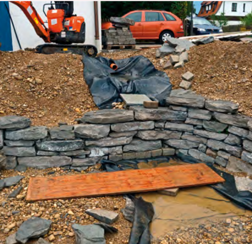
Sicht von unten. Sie sehen die fertige Trockenmauer, durch die das Regenwasser vom Anbau geführt wird. Die beiden Becken fehlen noch. Die Teichfolie liegt bereits hinter der Mauer.
