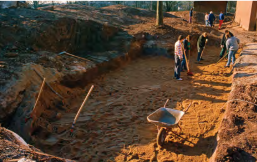
Sandschutzschicht 1. Betonplatten sollen es weich und bequem haben. Sie sind ja selber so hart drauf. Also 5 cm feinen Sand untergeben.
