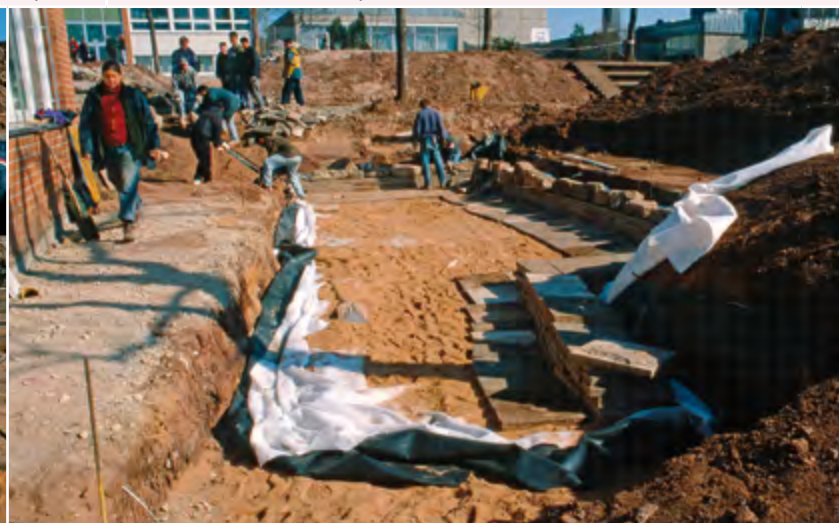
Randbereich schützen. Die Platten werden noch zwei Reihen in den Teich gelegt. Mehr muss nicht. Wir haben keine Betonplatten mehr! Wir könnten links Bauleiterin Sigrun Lobst fragen, die vorbeiläuft und vor ein paar Minuten unützerweise noch Lehm hin- und herschaufelte (S. 96); aber die geht grußlos vorbei! Typisch! Halloooo? Fragen wir den Bauleiter. Doch wo ist genau? „Steeeeeäähhfan!“
