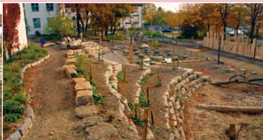
Frisch gebaut seitlich. Hier sieht man, wie die Treppen und Terrassen besät und bepflanzt wurden. Die Stöcke markieren jeweils ein wehrhaftes oder wuchsstarkes Wildgehölz. Alles andere hätte es schwer beim Spiel(be)trieb der Schüler.
