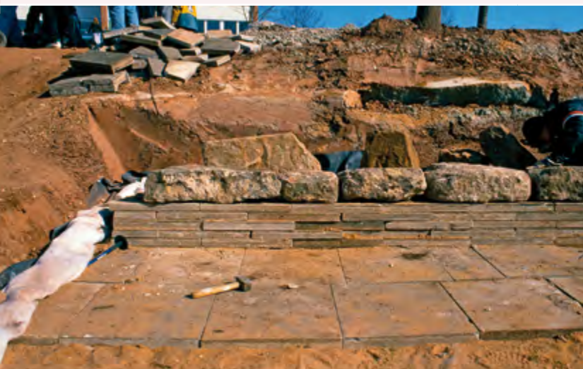
Platten und Natursteinmauer. Fünf Lagen Platten liegen noch unsichtbar im Wasser, die oberhalb der Wasseroberfläche herausguckende Mauer nun mit Natursteinen fortsetzen. „Steeeeeäähhfan!“
